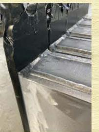
インコネル溶接とは、ステンレス鋼とクロム鋼などの異材質の溶接を行う為の特殊なインコネルという溶接棒を使い、密度の高い強靱な溶接が可能。
